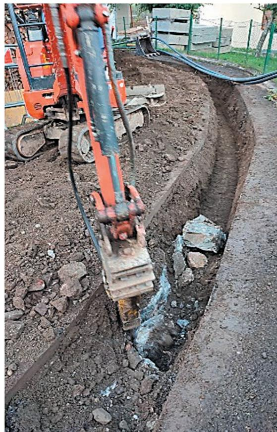
Anfang September haben wir in den Ortschaften Nafen und Teis mit der Verlegung von Elektroleitungen im Auftrag der Edyna, der Verlegung von Trink- und Regenwasserleitungen für die Gemeinde und dem Ausbau des Glasfasernetzes im Auftrag von Infranet begonnen.
